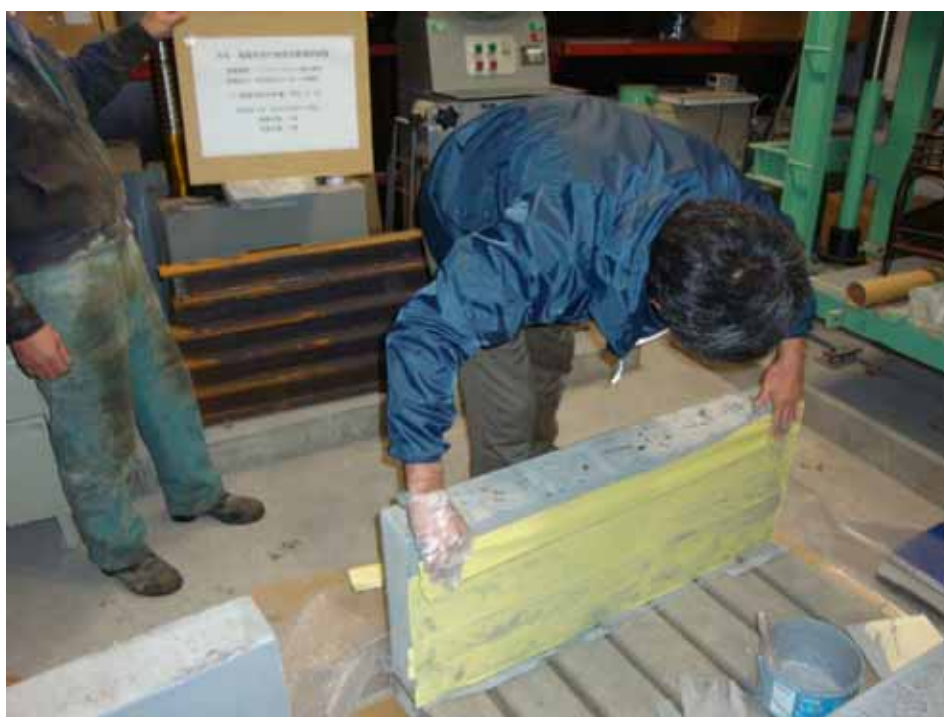
写真-6. 繊維布貼付作業中
