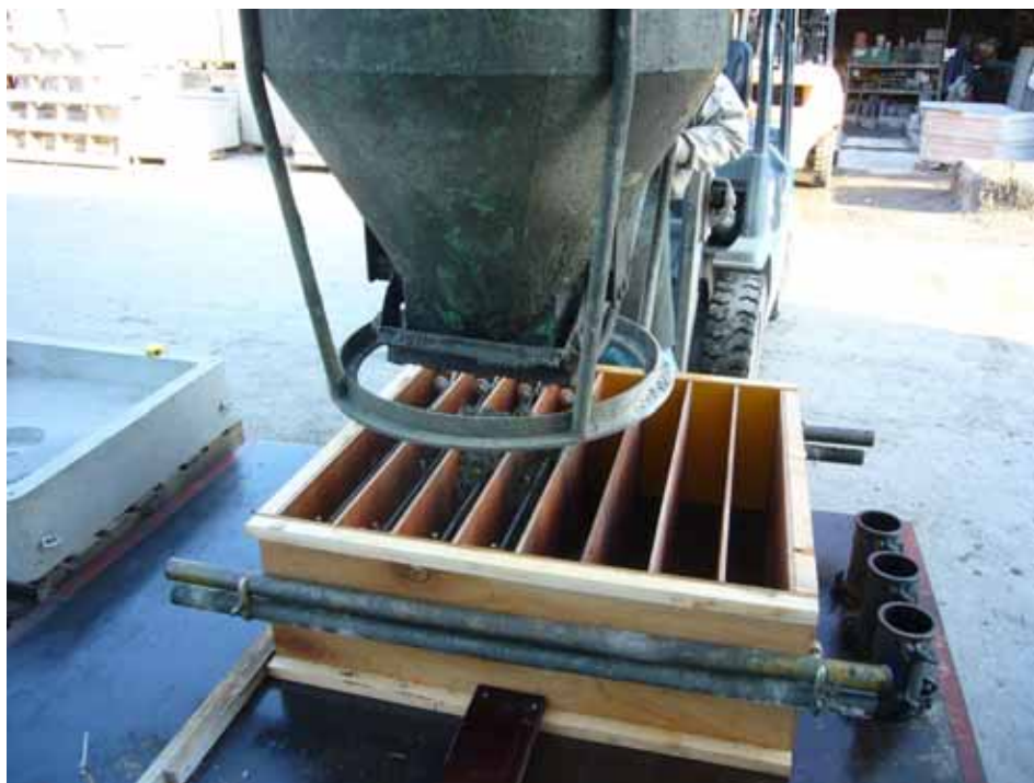
写真-3. コンクリート打設
