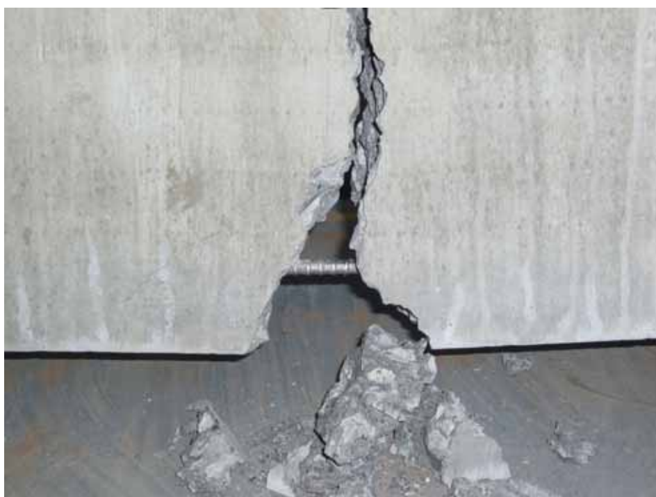
写真-11. 供試体内の降伏鉄筋の状況 [c-1：有筋・無補強]
