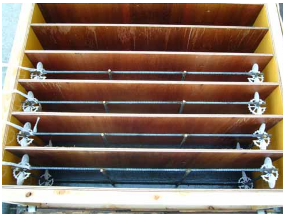
写真-2. 鉄筋配置状態
